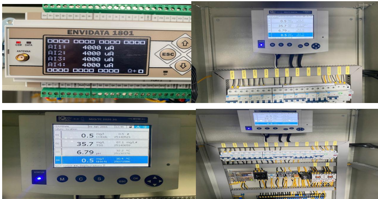
Hình 6. Hình ảnh thiết bị quan trắc nước thải tự động
